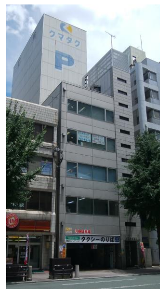
熊本タクシー本社ビル
